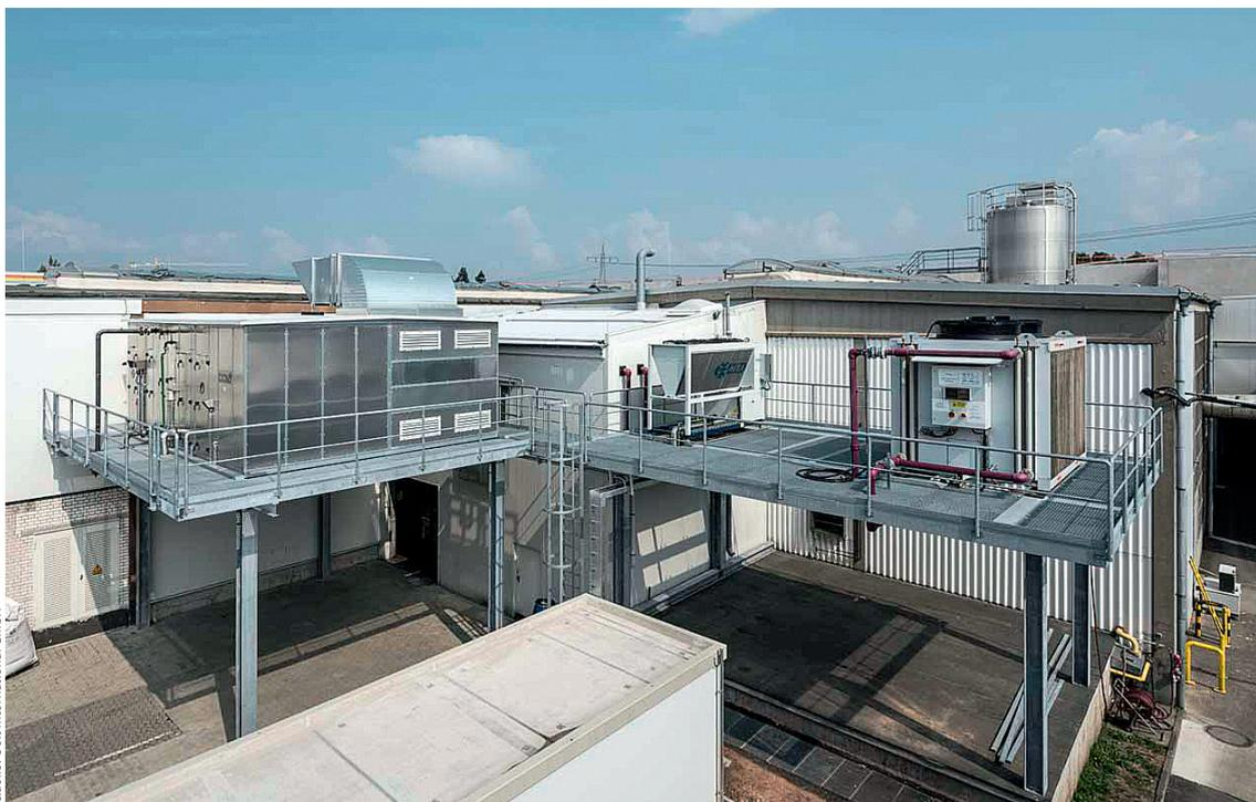
Colt-Tristar (KVS-Wärmerückgewinnung aus Prozessabluft, Verflüssigungssatz für den Direktverdampfer, adiabater Rückkühler für direkte Maschinenkühlung)
