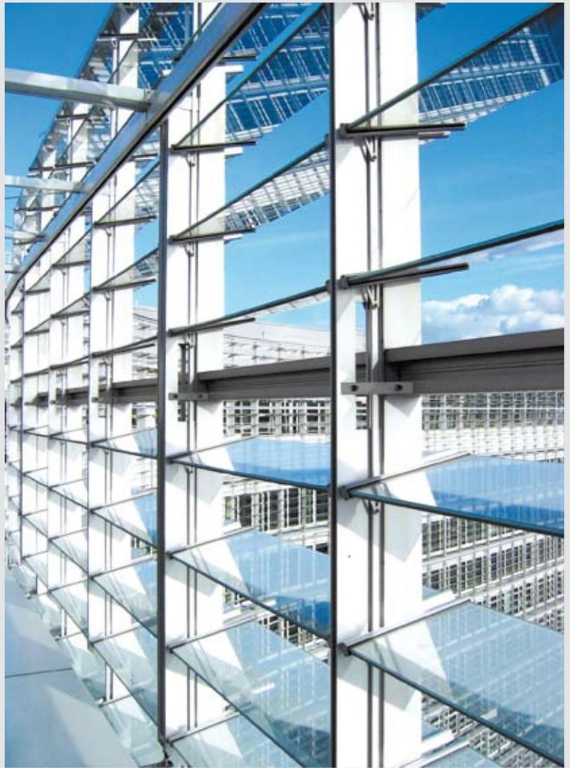
Großes Bild oben: Blick in die doppelte Fassade von "Berlaymont" – die Lamellen stehen auf Lichtlenkstellung.
